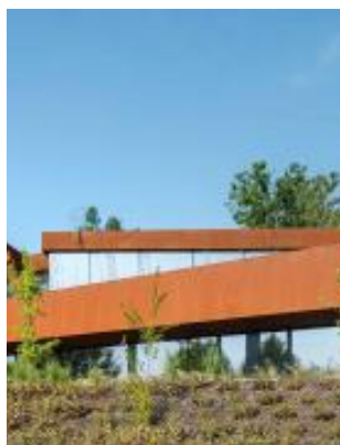
Una casa en acero que se construye...
